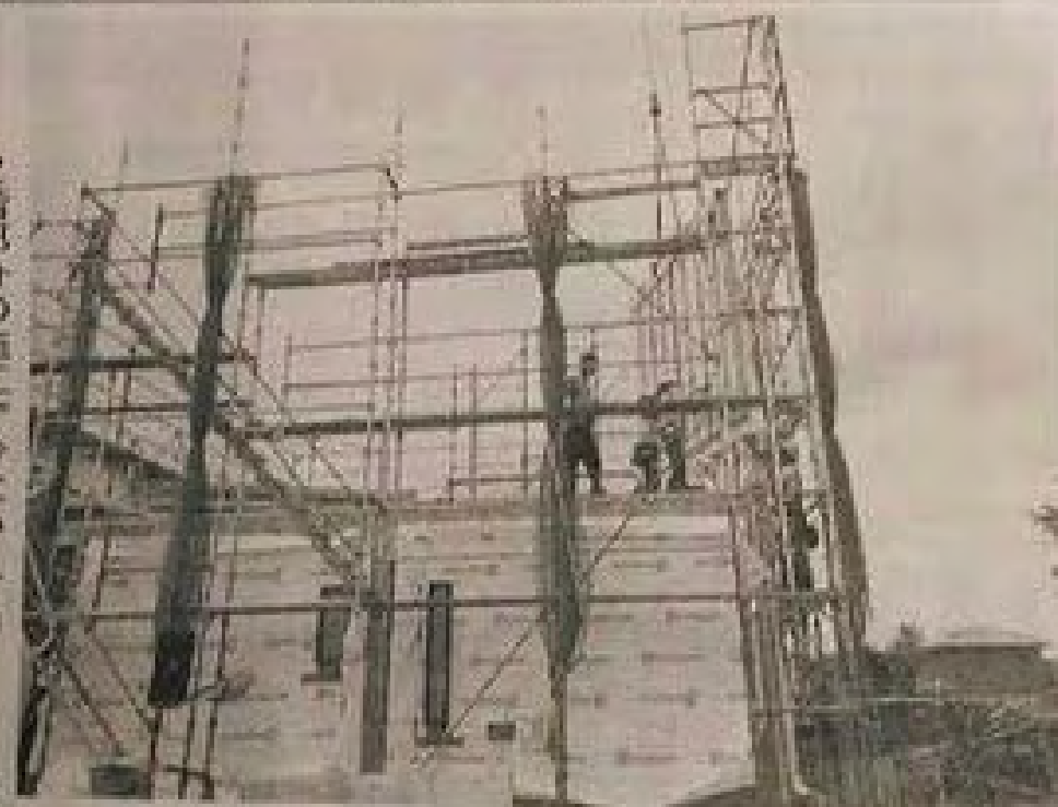
2階部分の施工。少ない人員で効率良く施工できる
